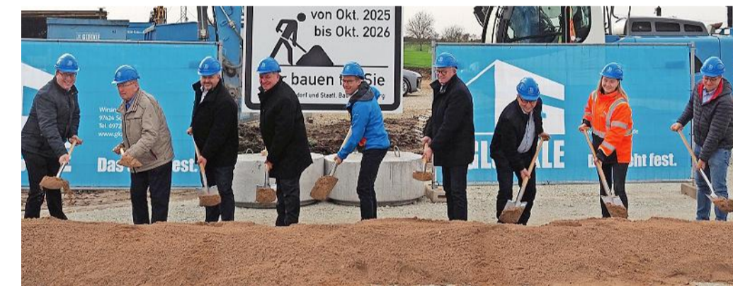
Spatenstich für die Westumgehung Geisfeld mit Staatsminister Christian Bernreiter.
